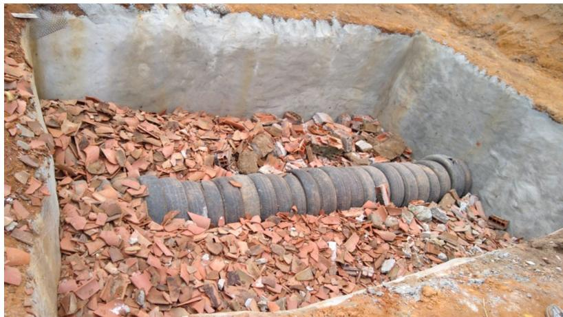
**5º PASSO:** Depositar uma camada de brita, com espessura de 10 a 14cm.
