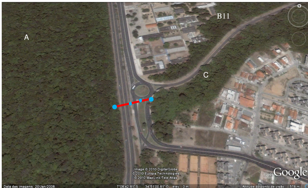
Figura 16: Vista aérea do ponto 1, que interliga o fragmento C ao fragmento A.
