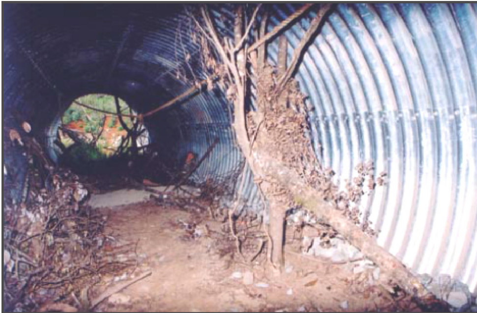
Figura 14: Túnel para passagem de fauna. Ornamentações imitam condições do ambiente natural. Cordas suspensas são amarradas em árvores dos dois lados do túnel para pequenos arborícolas obrigatórios, além de servir como rota de fuga contra predadores.
