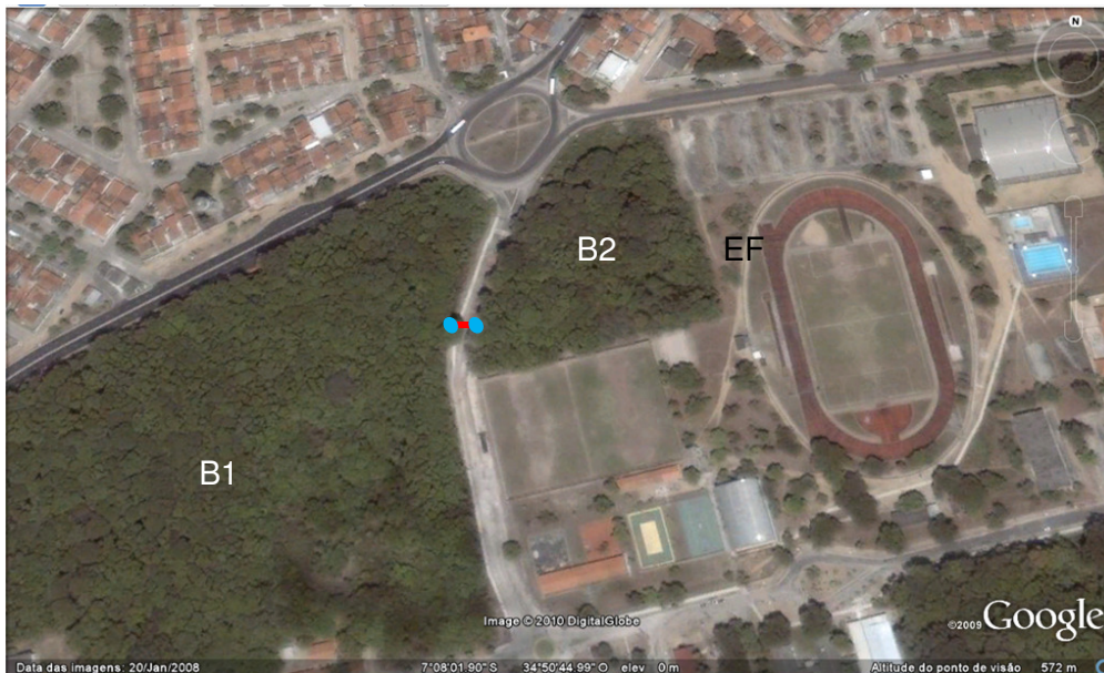
Figura 64: Vista aérea do ponto 15, ao lado de B2, onde haverá ponte e túnel interligando-o a B1.
