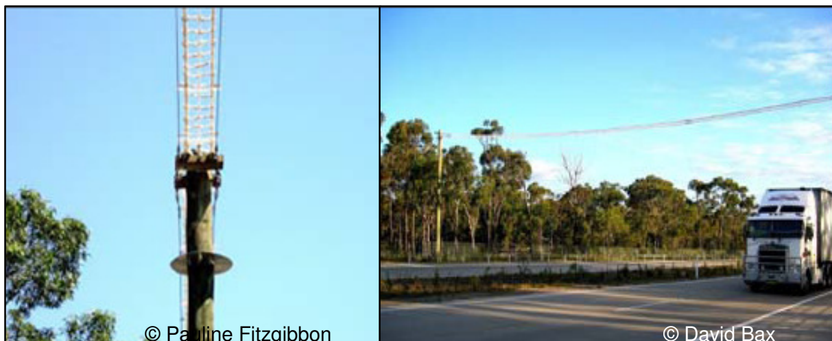
Figura 11: Pontes instaladas em áreas urbanas na Austrália.
