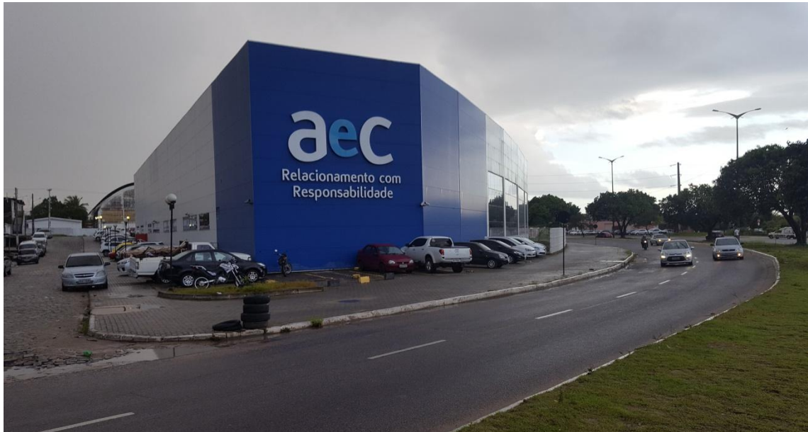
FIGURA 20 – CALL CENTER AEC NO TRECHO 1 DA AVENIDA HILTON SOUTO MAIOR.
