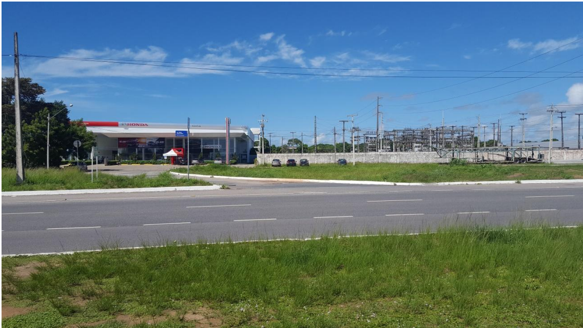
FIGURA 27 – LOJA DE MOTOCICLETAS AO LADO DE UMA SUBESTAÇÃO DE ENERGIA ELÉTRICA, NO TRECHO 2 DA AVENIDA HILTON SOUTO MAIOR.
