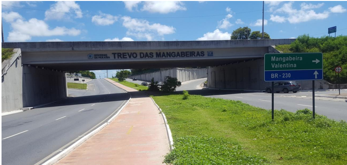
FIGURA 38 – TREVO DAS MANGABEIRAS NO TRECHO 2 DA AVENIDA HILTON SOUTO MAIOR.
