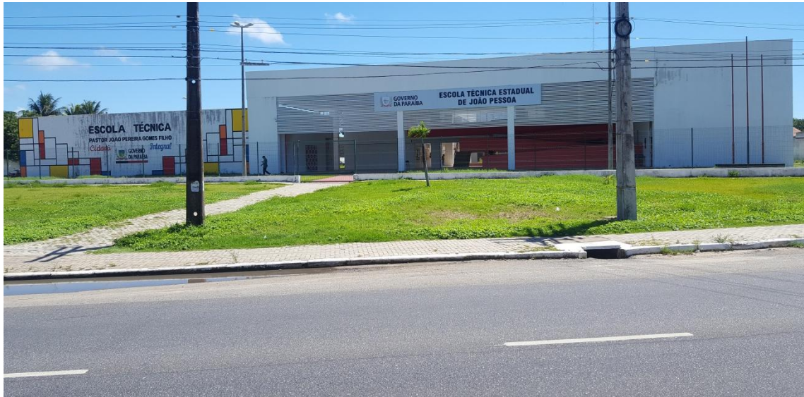
FIGURA 29 – ESCOLA TÉCNICA ESTADUAL DE JOÃO PESSOA NO TRECHO 2 DA AVENIDA HILTON SOUTO MAIOR.
