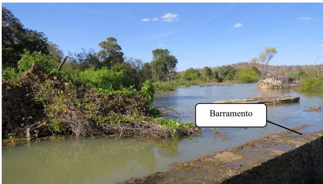
Figura 25: Fotografia apresentando barramento cruzando o canal confinado.
