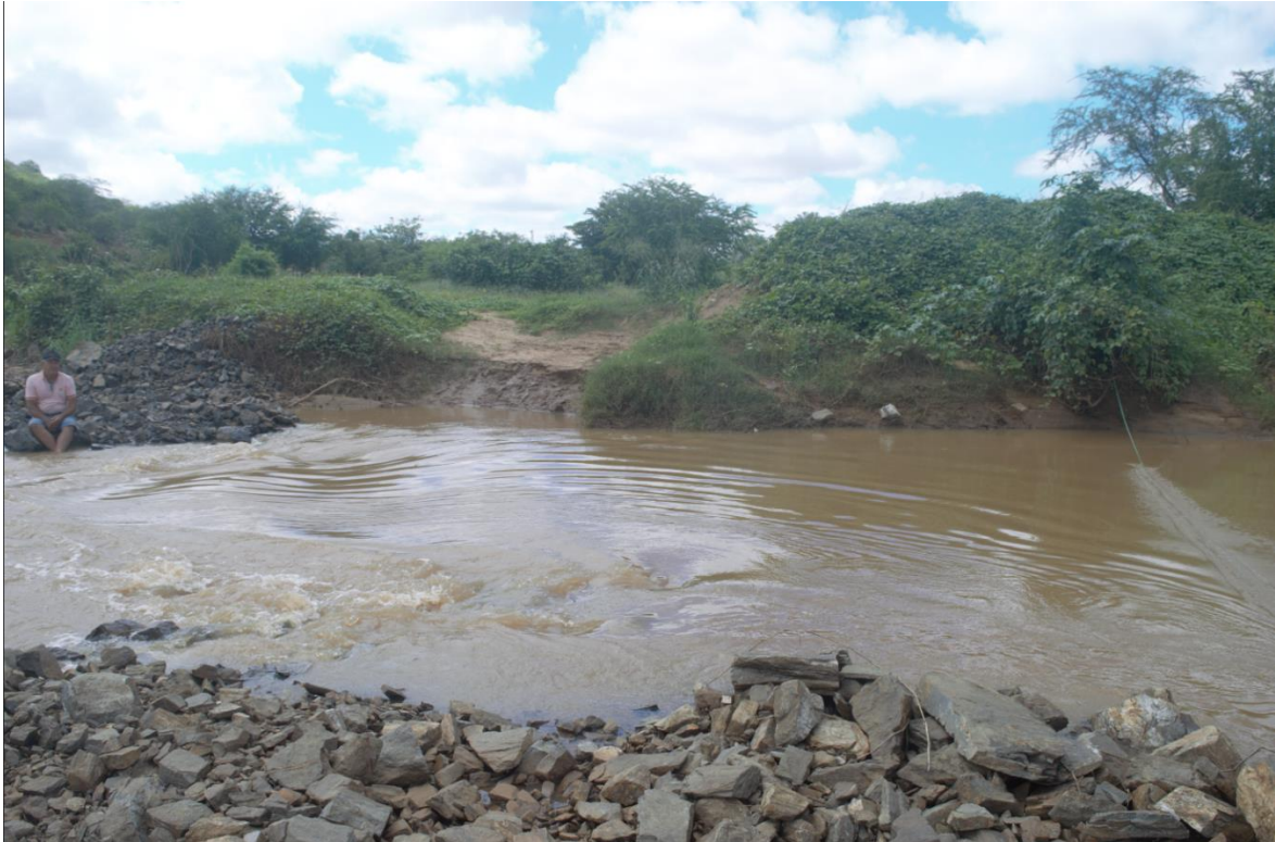
Figura 25 - Desvio e concentração de fluxo a partir da construção da passagem de pedra, São Domingos do Cariri (PB).
