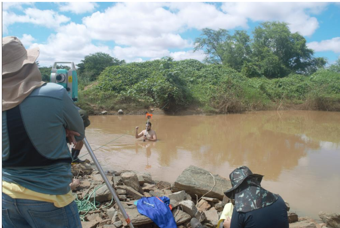
Figura 9 - Medições da topografia com estação total.
