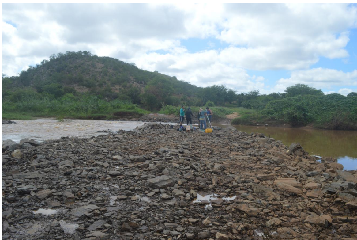
Figura 24 - Ponte em construção em Canal Semiconfinado com Ilhas de Vegetação (CSIV), São Domingos do Cariri (PB).
