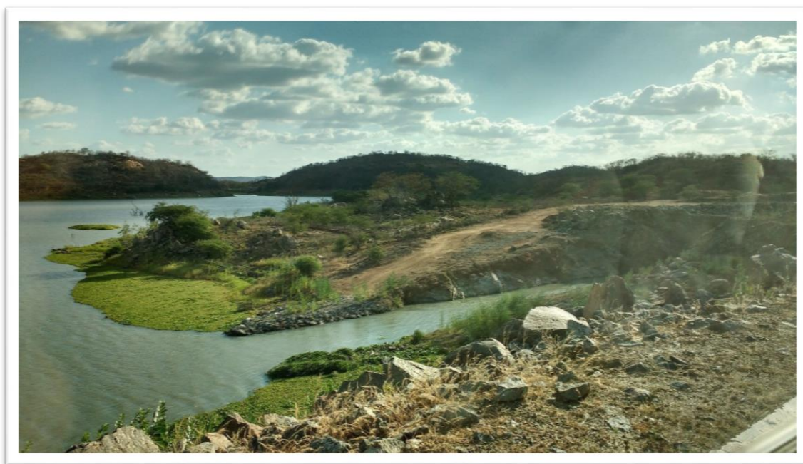
Figura 45 - Trecho desviado no Açude Camalaú (PB).
