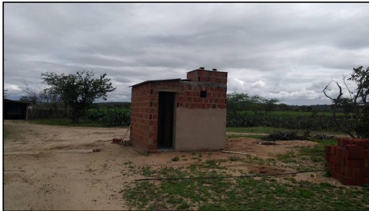
Figura 6 – Banheiro em construção no estabelecimento agropecuário do integrado à Frango Dourado
