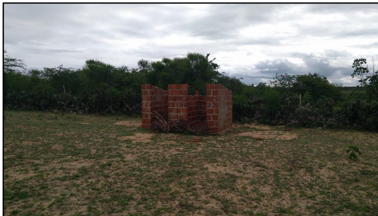
Fotografia 7 – Casa da compostagem em construção no estabelecimento agropecuário do integrado à Frango Dourado
